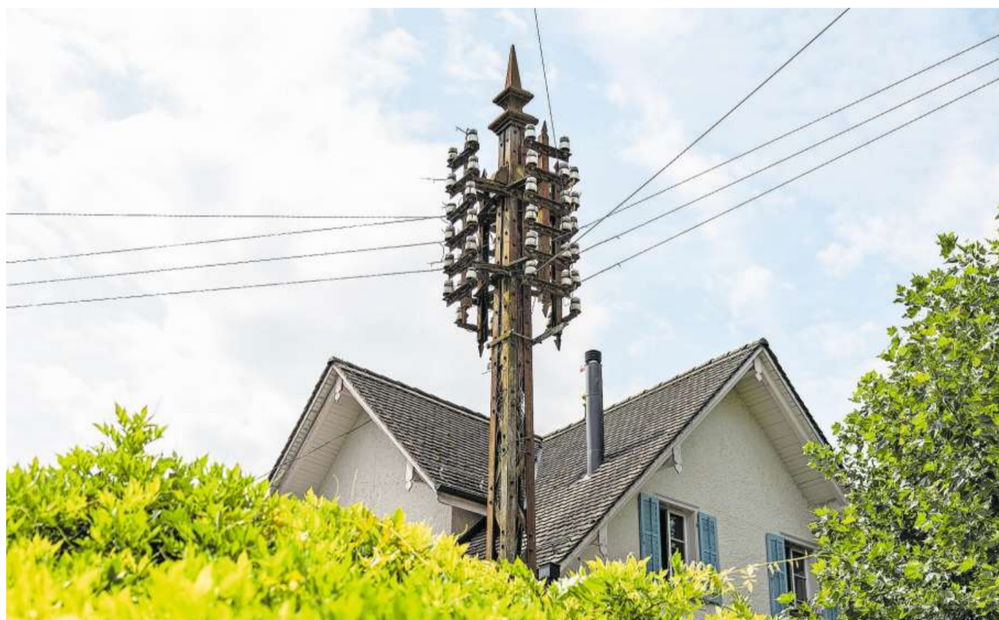
Der Telefonmast am Vierherrenplatz in Sursee.
