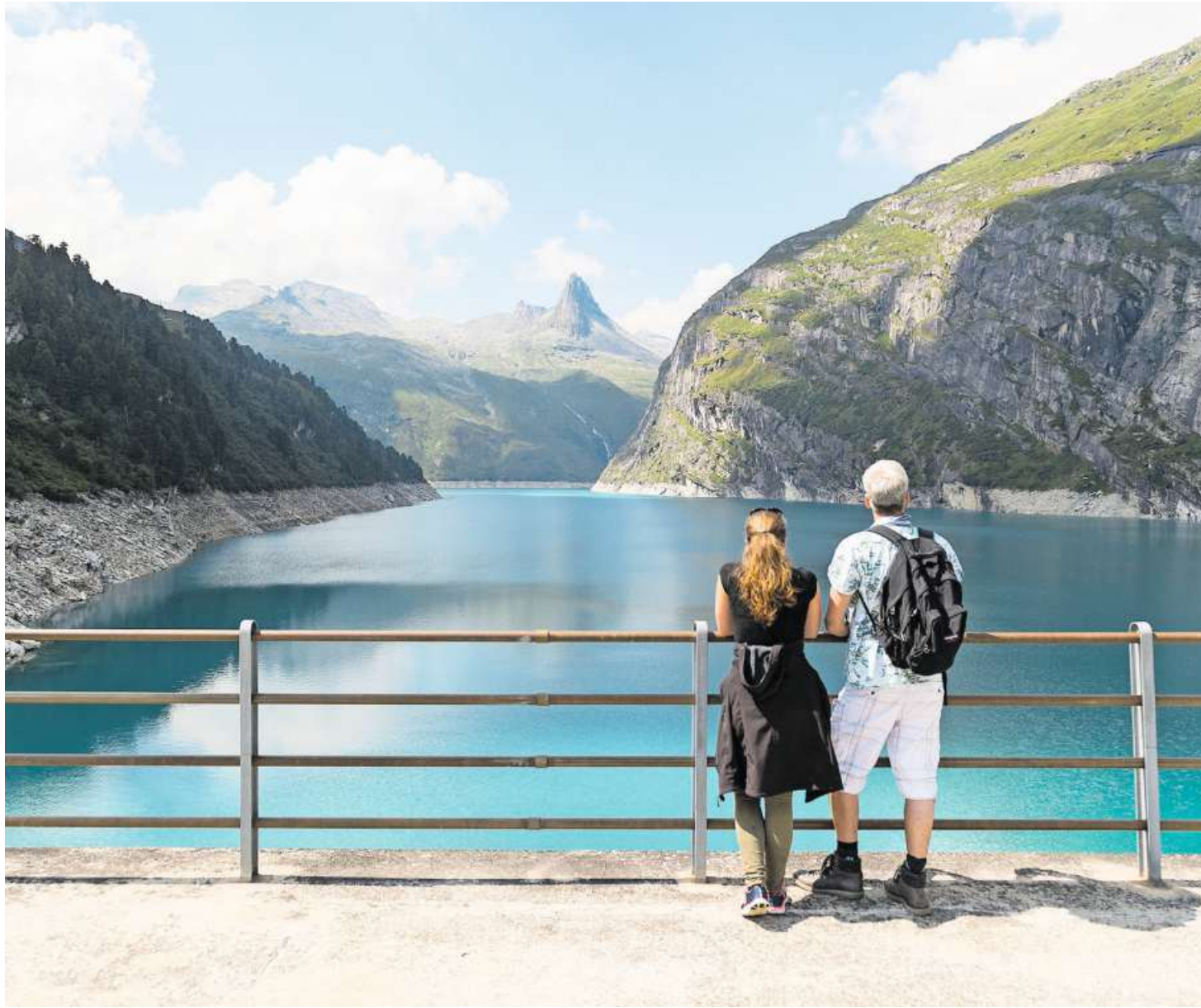
Der Zervreila-Stausee in Vals GR. Die jährlich produzierte Energiemenge reicht zur Versorgung von rund 110 000 Haushalten.
