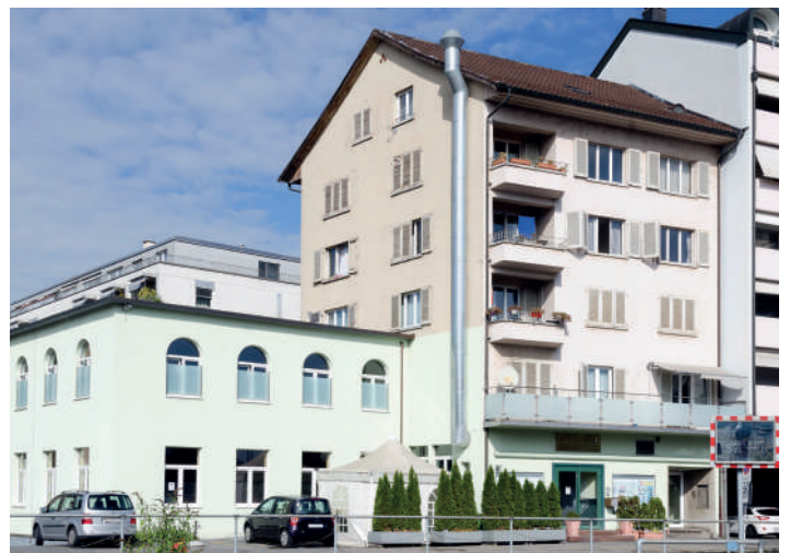
Bild 7: Die bosnische Moschee (Dzemat) in Emmenbrücke, eingerichtet in einem ehemaligen Kino.
