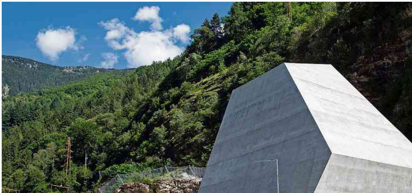
Die neue Eisenbahn-Ästhetik: Betonarchitektur beim Südportal des Basistunnels in der Leventina.
